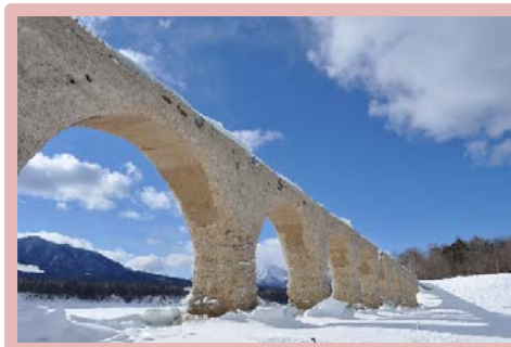
上士幌のみどころ 【旧国鉄士幌線コンクリートアーチ橋梁群】
