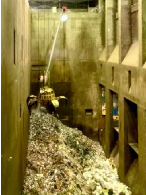
NO.1 放水銃で火種付近を消火している様子。(11月30日、⑦)
