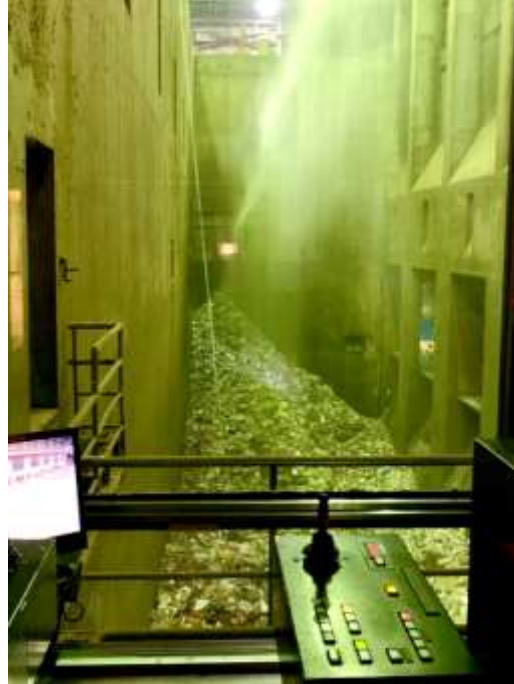
NO.2 放水銃で火種周辺を消火している様子。(11月30日、⑧)
